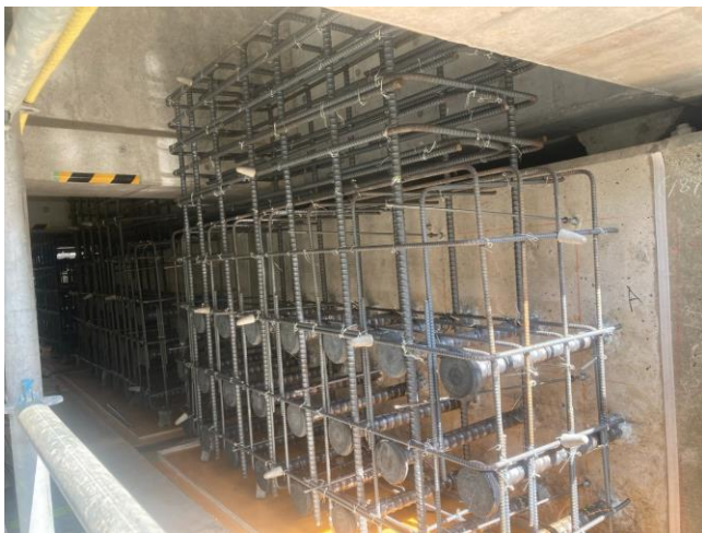
①古宮高架橋 左：鉄筋組立完了(5AA・5AB) 右：生コン打設状況(5AA・5AB)
