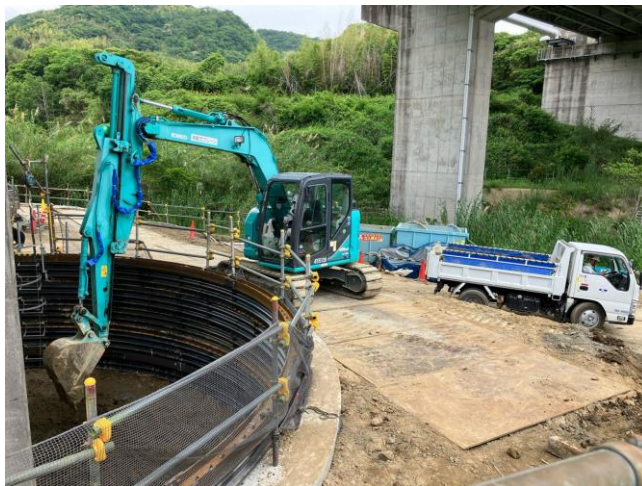
②中田川橋 左：施工状況全景 右：ライナー掘削状況(3PB)
