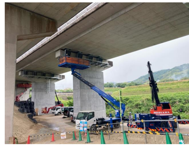
③双又川橋 左：検査路設置状況(4PA) 右：鋼製ストッパー・ブラケット設置、検査路設置完了(3PA・4PA・5PA)
