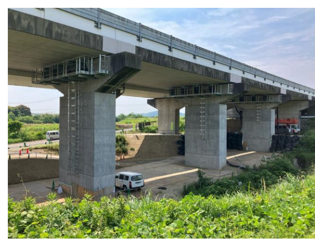
③双又川橋 左：検査路設置状況(4PA) 右：鋼製ストッパー・ブラケット設置、検査路設置完了(3PA・4PA・5PA)
