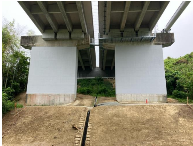
①古宮高架橋 左：施工状況全景 右：耐震補強完了4PA・4PB)
