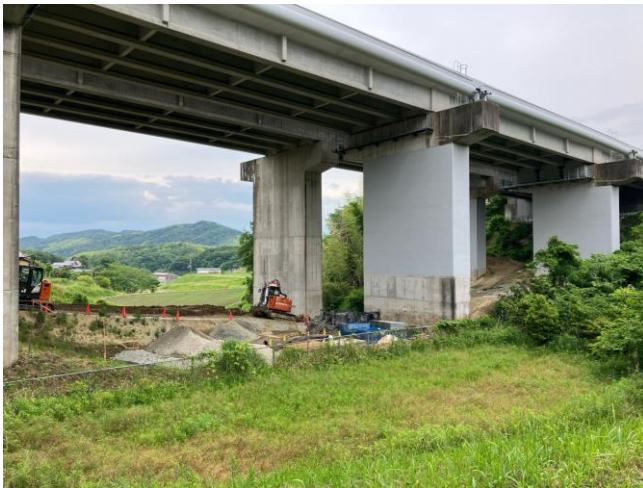
①古宮高架橋 左：施工状況全景 右：耐震補強完了4PA・4PB)
