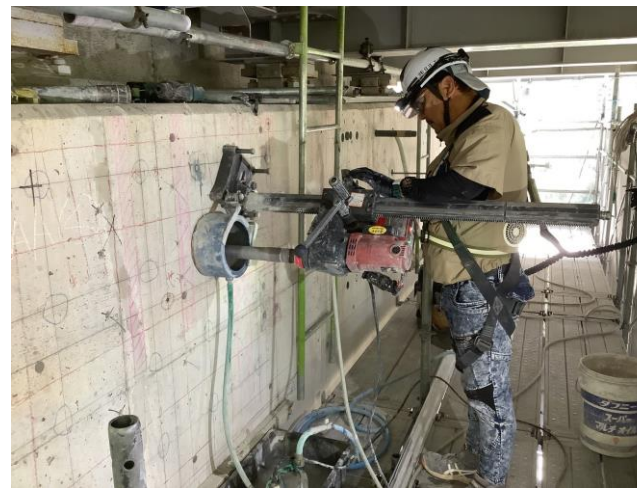
④琵琶川橋 左：アンカー削孔(1AA) 右：ヤード整備状況(2P)
