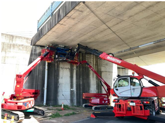
③双又川橋 左：施工状況全景 右：鋼製ストッパー設置状況（1AA）
