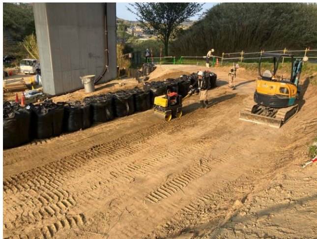
②中田川橋 左：ライナー掘削状況(3PA) 右：迂回路造成状況(4AA・4AB)
