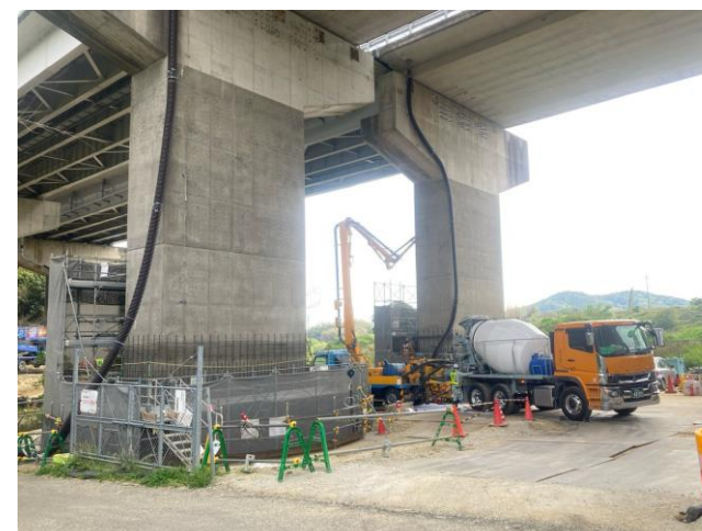
④琵琶川橋 左：型枠組立完了(3PB) 右：生コン打設状況(3PA・3PB)
