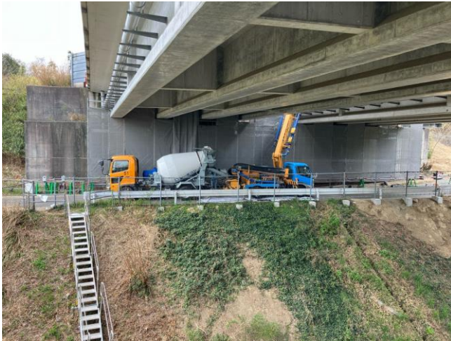
①古宮高架橋 左：生コン打設状況(5AA・5AB) 右：RC突起施工完了(4PA・4PB)
