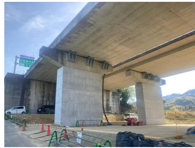
④琵琶川橋 左：鋼製ストッパー・ブラケット設置完了(7PA・7PB) 右：アンカー定着状況(5PB)
