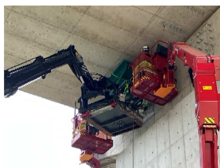
④琵琶川橋 テレハンドラーによる鋼製ストッパー取付状況(6PA)
