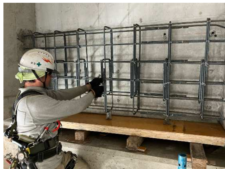
①古宮高架橋 左：緩衝ゴム設置状況(4PA) 右：鉄筋組立状況(5AA)
