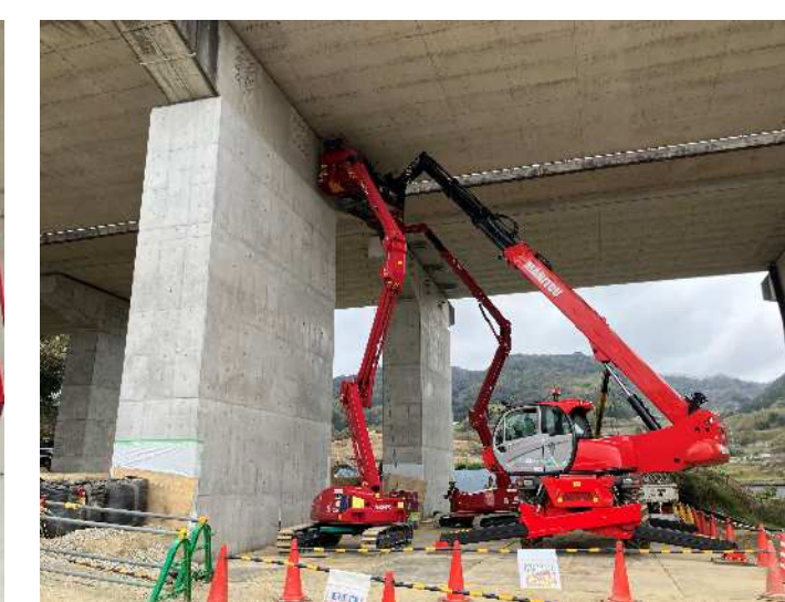
④琵琶川橋 テレハンドラーによる鋼製ストッパー取付状況(6PA)
