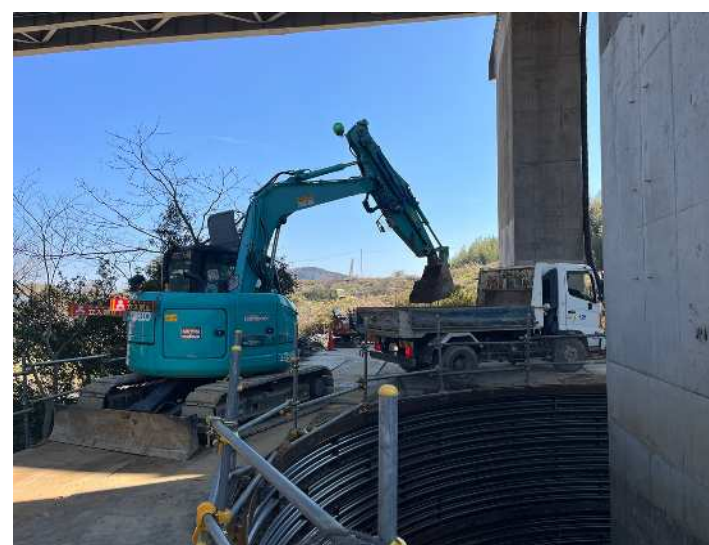
④琵琶川橋 左：ライナー掘削状況(3PA) 右：テレハンドラー先端状況
