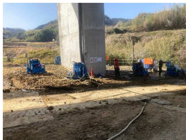
②中田川橋 左：施工状況全景 右：薬液注入工施工状況(3PA)
