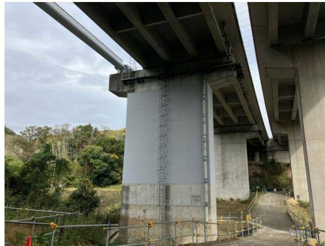
①古宮高架橋 左：施工状況全景 右：アラミド繊維補強完了(3PA)
