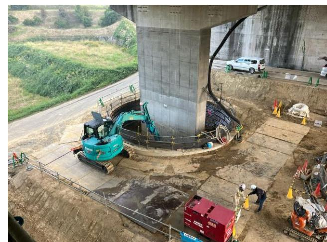
④琵琶川橋 左：アンカー削孔状況(3PAB) 右：構造物掘削状況(7PB)
