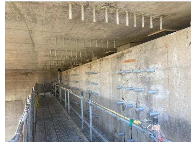
③双又川橋 左：生コン打設状況(4PA) 右：アンカー定着完了(1AB)
