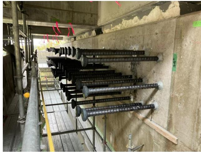
②古宮高架橋 左：アンカー定着状況(4PB) 右：アンカー定着完了(4PB)
