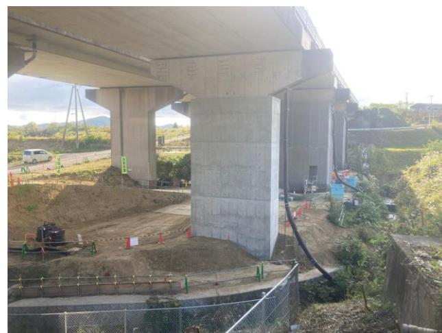
③双又川橋 左：施工状況全景 右：RC巻立て補強完了全景(3PA)
