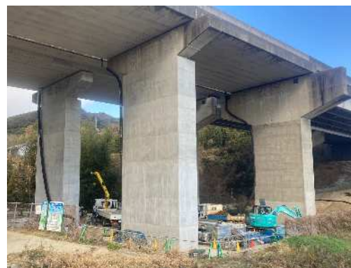
④琵琶川橋 左：RC巻き立て補強完了(4PA・4PB) 右：ライナー掘削(3PB)
