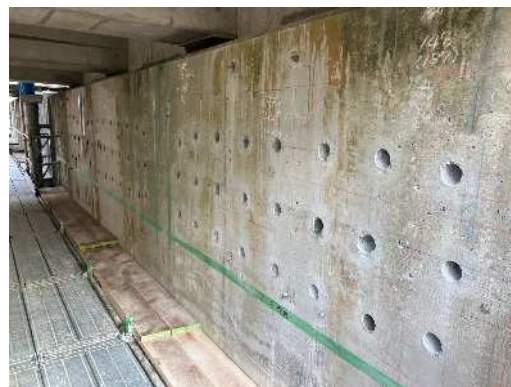
①古宮高架橋 左：施工状況全景 右：アンカー削孔完了(5AA)
