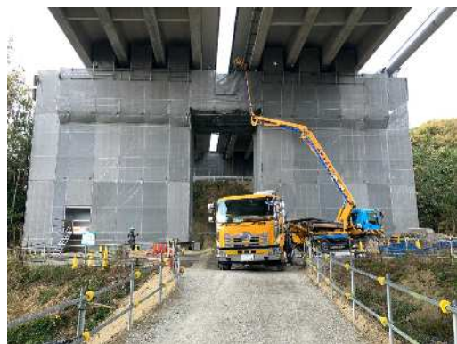
①古宮高架橋 左：生コン打設状況(4PA) 右：生コン打設完了(4PA)
