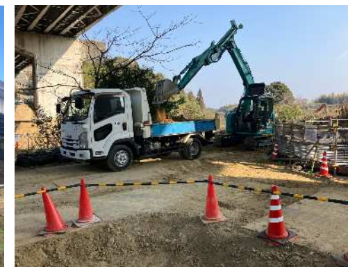
④琵琶川橋 左：RC巻き立て補強完了(4PA・4PB) 右：ライナー掘削(3PB)
