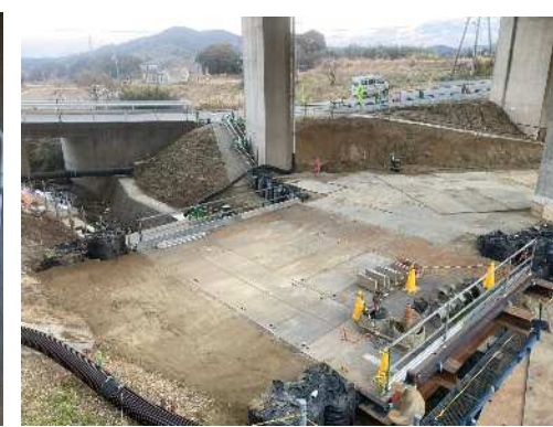
③双又川橋 左：施工状況全景 右：覆工板設置状況(2P・3P)
