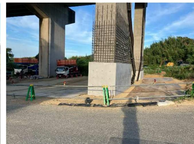
④琵琶川橋 埋戻し工 左：転圧状況 右：埋戻し完了
