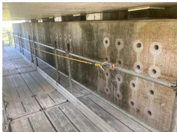
③双又川橋 左：ライナープレート掘削完了 右：アンカー削孔完了
