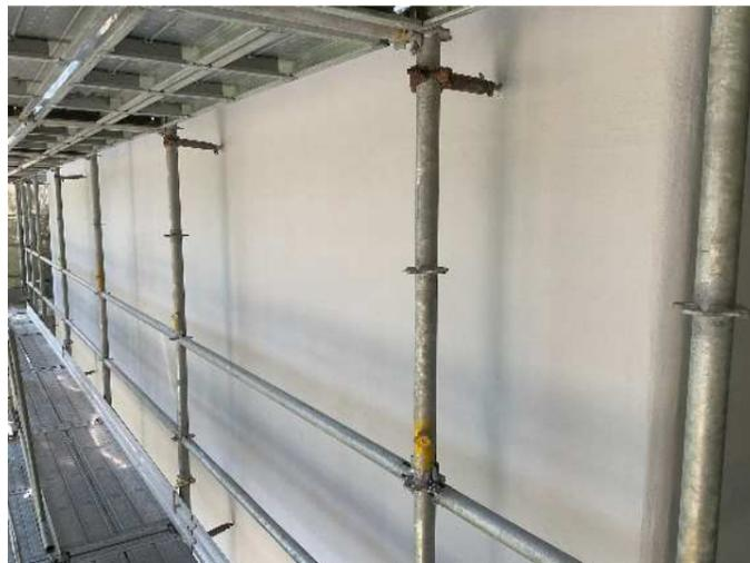
①古宮高架橋 アラミド繊維補強 (左：表面保護材塗布状況 右：施工完了)
