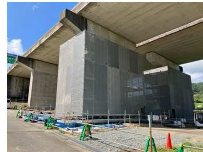
④琵琶川橋 左：ライナープレート掘削状況 右：足場組立完了
